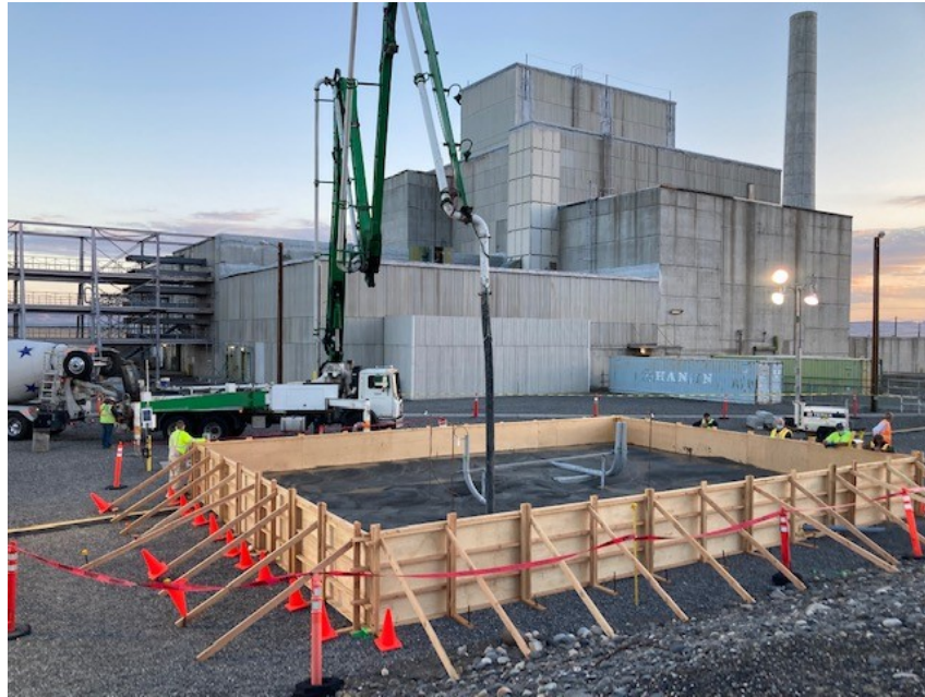
CDF pour for construction of substation pad
